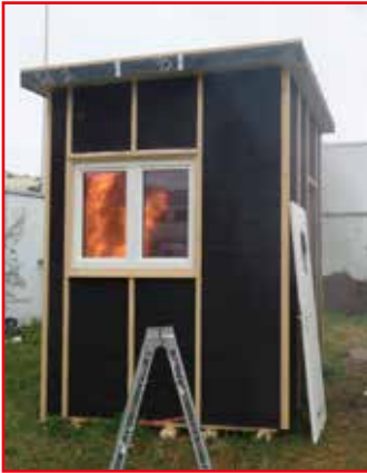
Abbildung 1: Im Projekt Brand_Wasser_Schaden wurden Sanierungsmaßnahmen anhand realer Brandereignisse untersucht.
