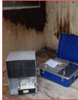
Abbildung 3: Laufende Messungen der Holzfeuchtigkeit im Zuge von Trocknungsmaßnahmen.
