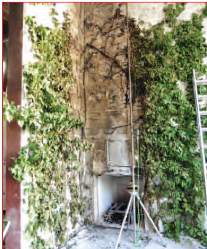
Abb 4: Fassadenbegrünung nach der Prüfung – keine seitliche Brandweiterleitung erkennbar.
