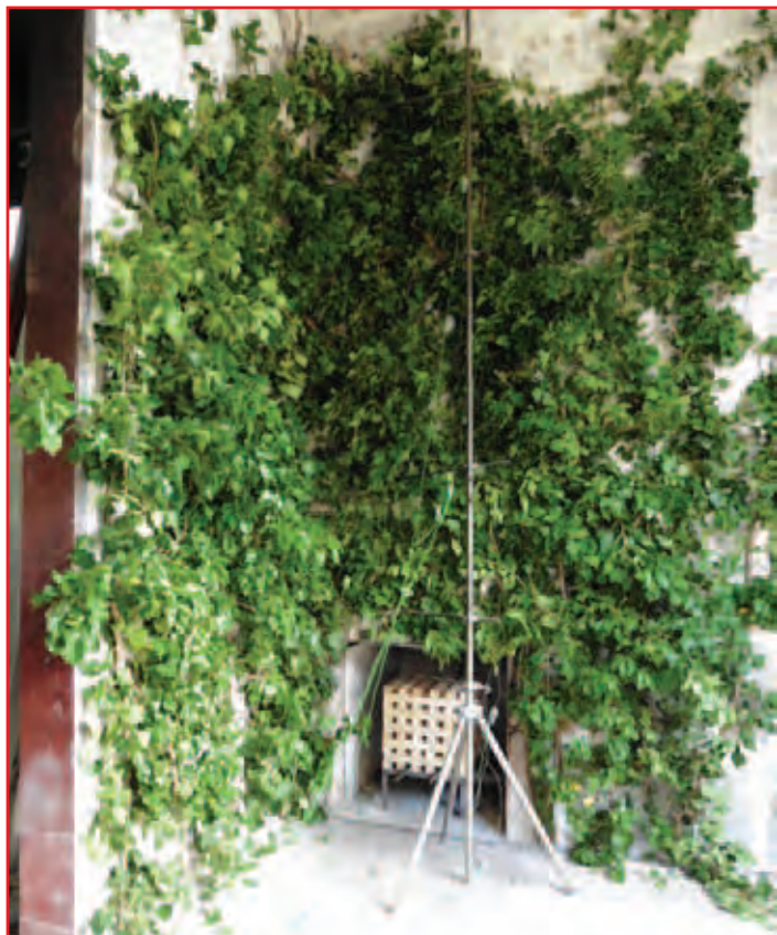
Abb 1: Efeu am Prüfstand der MA 39 vor der Fassadenbrandprüfung.
