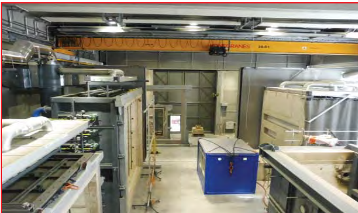
Bild 4 (Quelle MA 39): Blick in die Prüf- und Prüfgut Aufbauhalle
