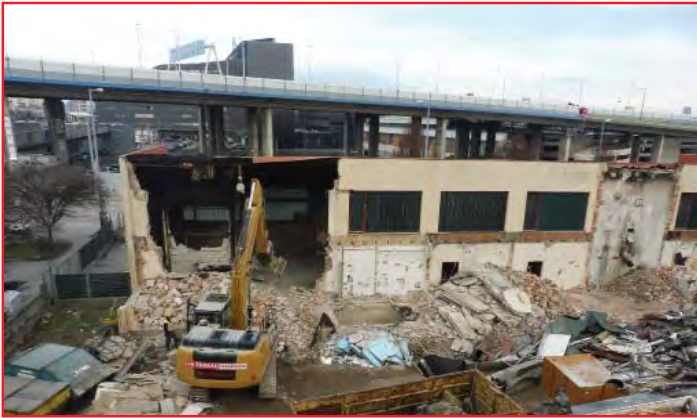
Bild 1 (Quelle MA 39): Abriss der „alten“ Brandprüfhalle
