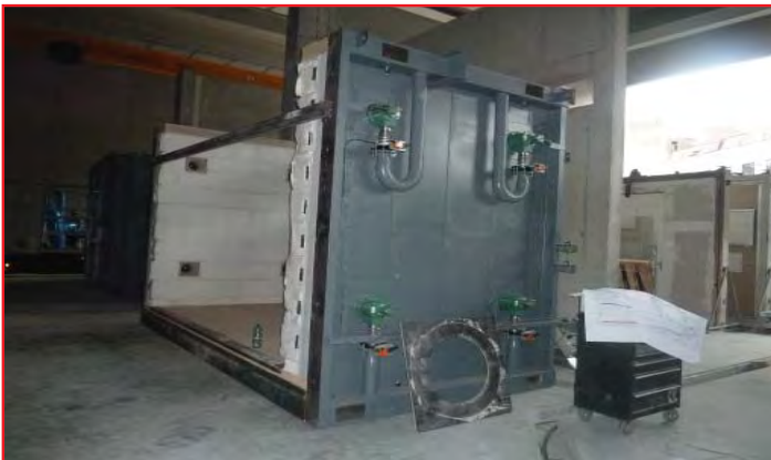
Bild 3 Errichtung eines Gebäudekomplexes inkl. Brandprüfhalle
