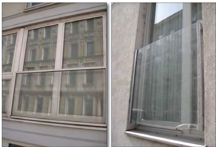
Abb. 1: Brandschutzschild vor einem zweiflügeligen Element. Abb. 2: Brandschutzschild mit seitlichem Stahlrahmen (Quelle: D. Werner).
