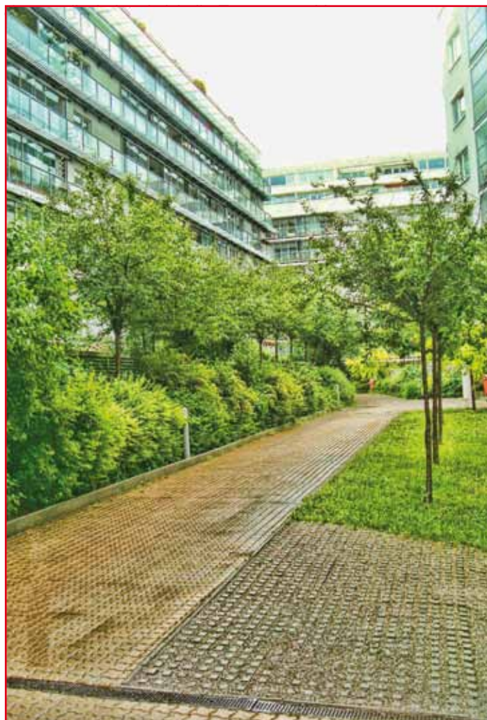
Bild 3: Feuerwehrzufahrten und –aufstellungsflächen. Weiß die Verwaltung dieses Wohnhauses, dass der Bewuchs die Anleiterbarkeit der Wohnungen nicht behindern darf? Wird eine entsprechende Baumpflege durchgeführt?
