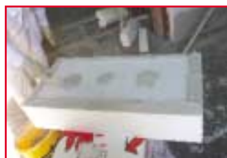
Bild 5: Verklebung der EPS-Platten (Rand-Wulst-Punkt-Methode)
